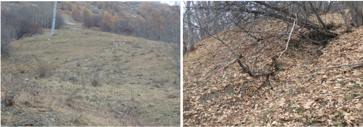
Figure 13 : zone "lessivée" avec coulée à gauche, zone érodée en fossé à droite
