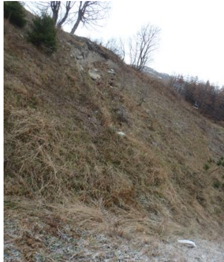
Figure 8 : niche d'érosion ayant occasionné des chutes de blocs
